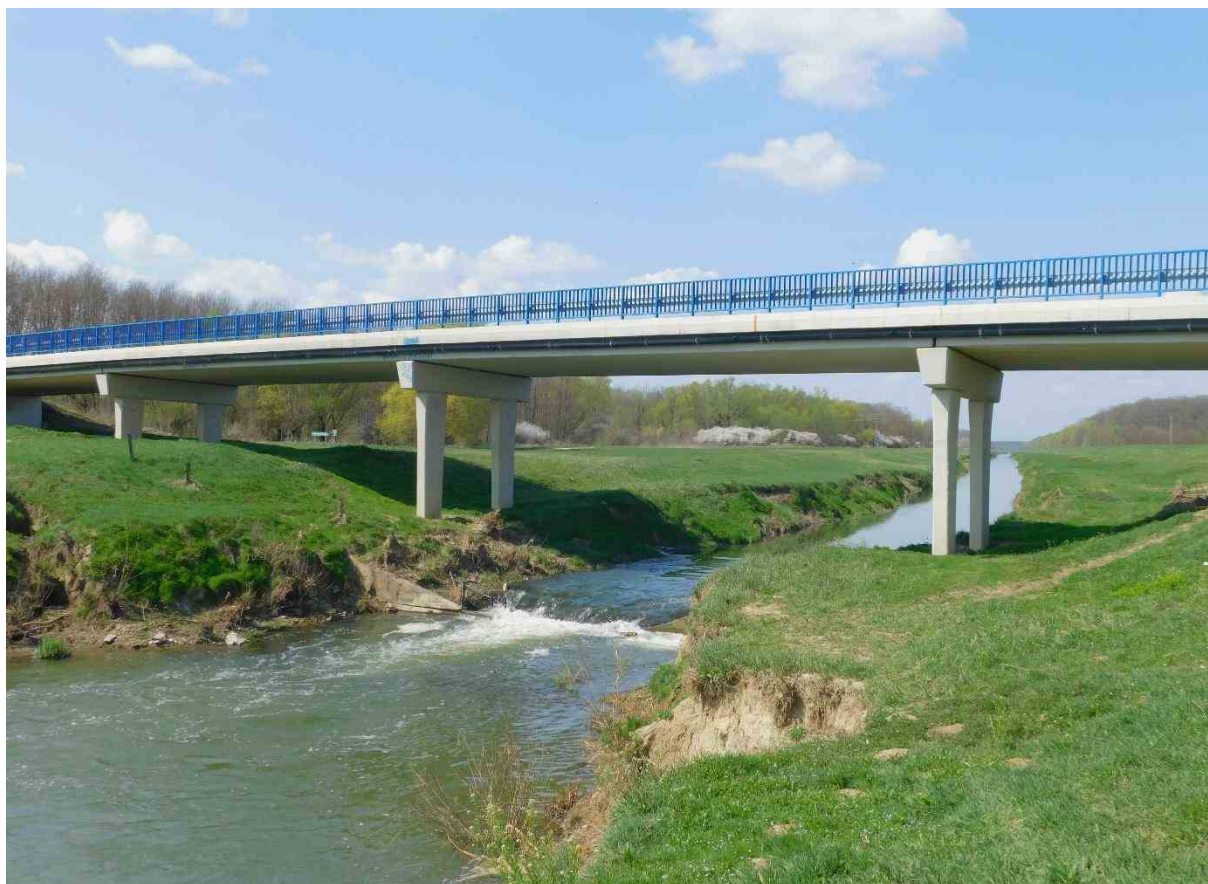
Fotografija 2 - Most iznad rijeke Glogovnice, naselje Stara Marča, travanj 2026.
