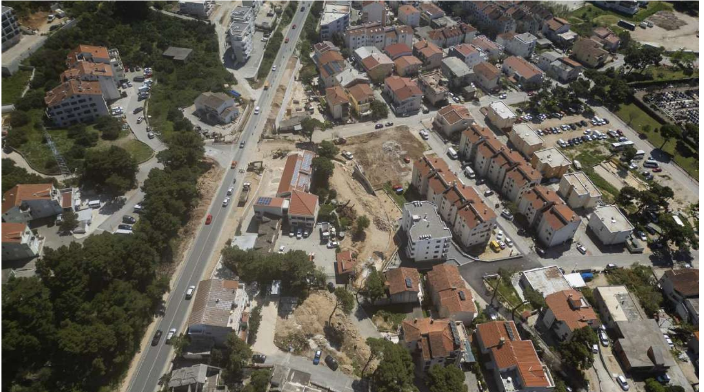
Snimak dronom gradilišta spoja Kotiške ulice na magistralu u Makarskoj, 06.04.2024
